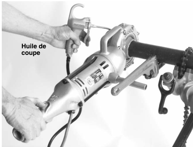
Figure 6 – Filetage en utilisant une clé à tubes comme étrésillon
